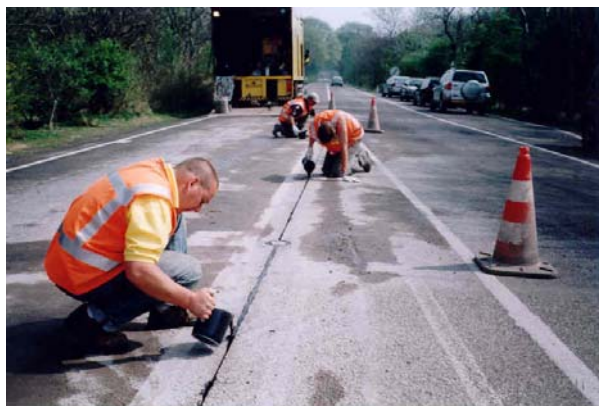
Afgieten van de zaagsnede voor het plaatsen van de actieve LED-markeringen op de as van de weg
