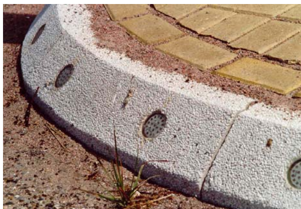
Ronde units met witte LEDs worden in standaard Rijkswaterstaat trottoirbanden geboord
