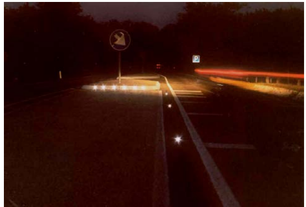
Situatie bij nacht Door een passerende auto ontbranden de LEDs gedurende een minuut
