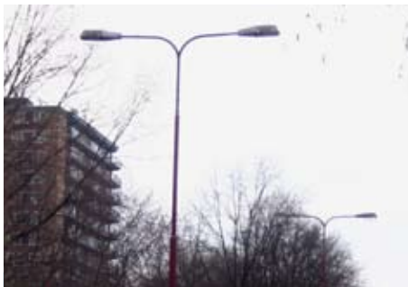
Oude situatie: lichtmasten van 9 meter met een lamp van 150 Watt (SOX-lamp).
